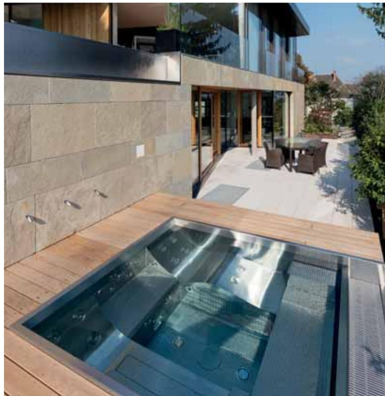
Whirlpool 2 x 2 m mit stirnseitiger Überlaufrinne, Massageliegen und Unterflur-Rolloabdeckung unter der Sitzbank versteckt
