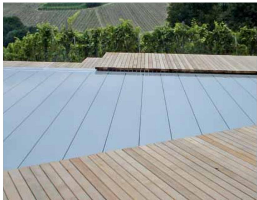
Eine Hubboden-Konstruktion ermöglicht stufenlos verstellbare Wassertiefen und erfüllt gleichzeitig auch die Abdeckfunktion.
