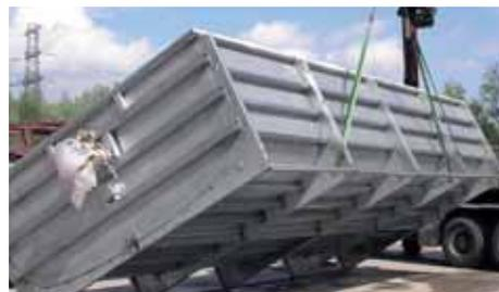
Der Pool wird fertig geliefert und vor Ort montiert. Bauzeit und Kosten werden dadurch minimiert.
