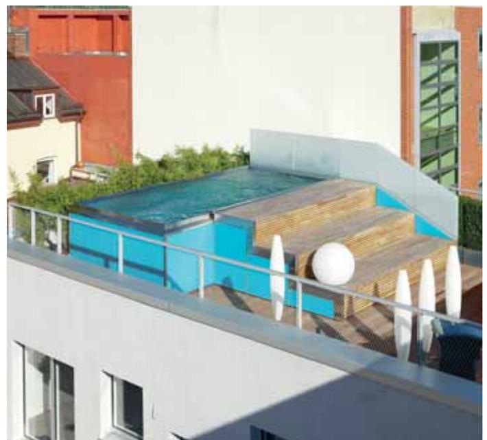
Die Treppenkonstruktion dient als Sitz und Liegefläche und nimmt die gesamte Schwimmbadtechnik auf.
